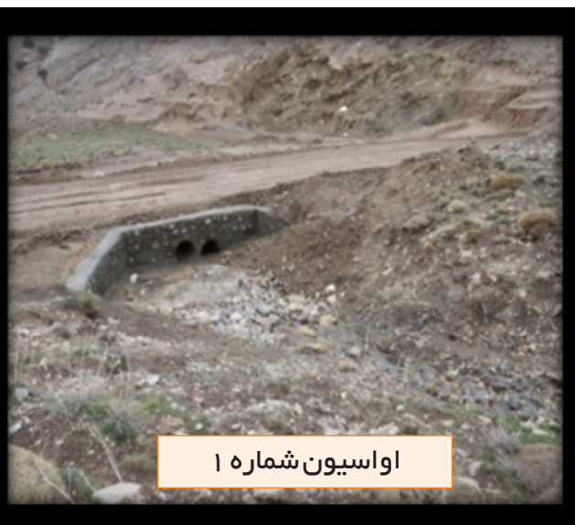
شکل ۱۵. لوله‌های جفتی کار گذاشته و سازه‌های در اواسیون احداث شده در معدن تاش
